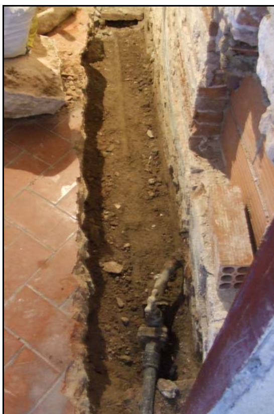
Fotografia núm. 2: Vista de la rasa 200
